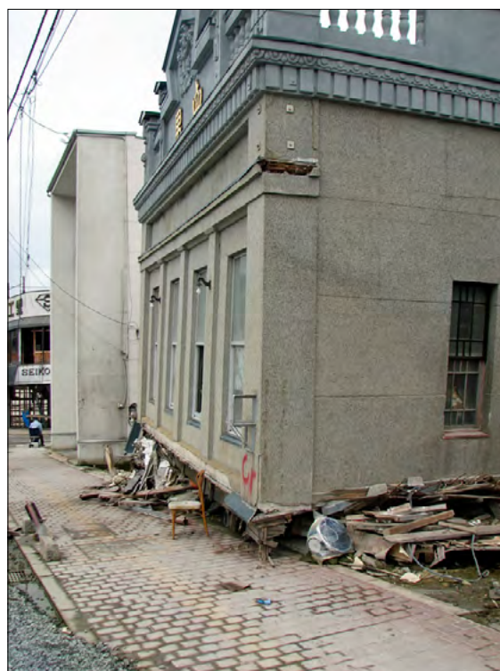
気仙沼市魚町にある酒屋。1階部分が損壊して潰れてしまっている。
