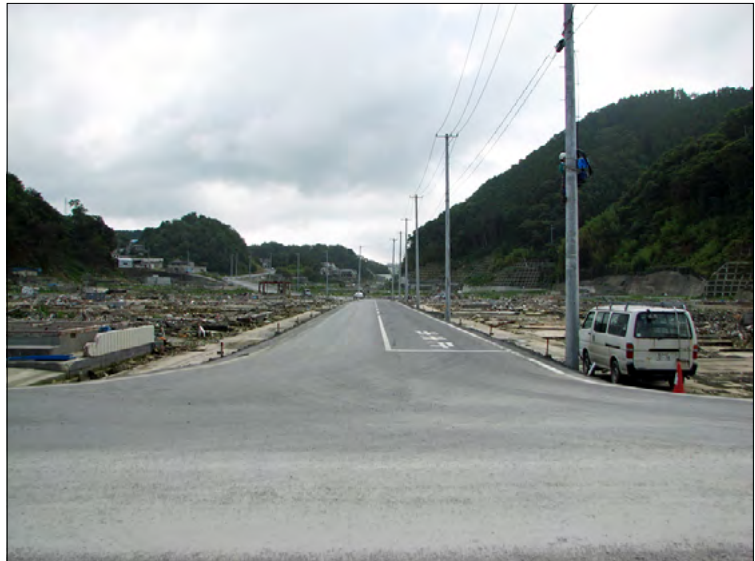
女川町鷺神浜。女川町の中心部から女川バイパスを望む。道の両側は津波により全壊している。
