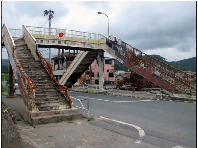
気仙沼市鹿折地区にある歩道橋。津波と火災によって鉄製の手すりが歪んでしまっている。
