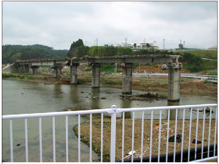
気仙沼市陸前小泉駅近くの鉄橋。途中で橋が流されている。
