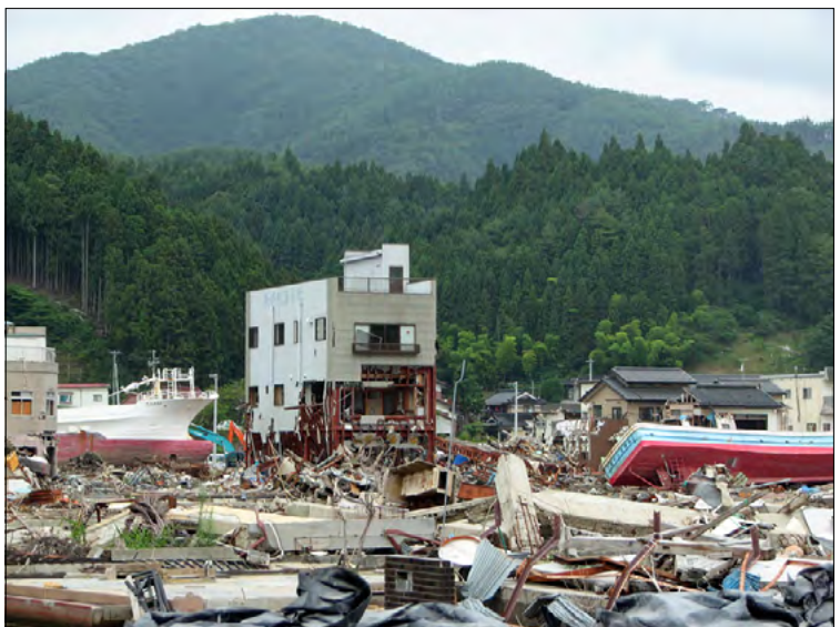
気仙沼市浜町。建物は損壊し見る影もなく、至る所に乗り上げた船がある。
