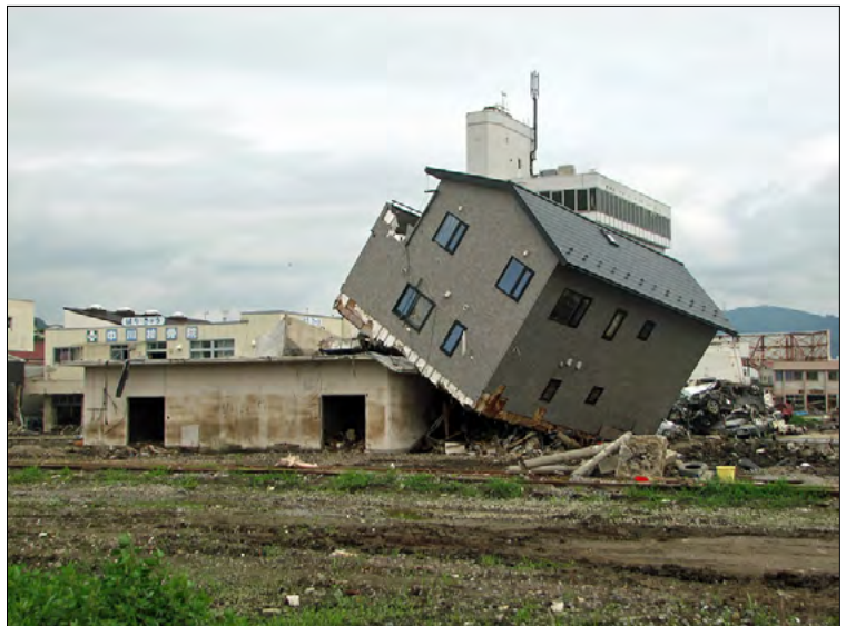
南気仙沼駅。駅構内の建物の上に乗っている家は、どこからか流れ着いたものらしい。
