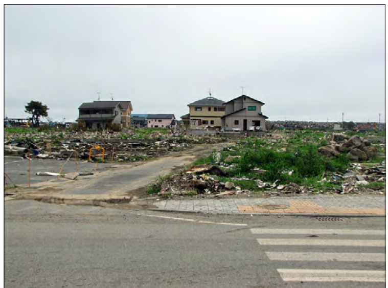
石巻市門脇町。ここは何軒か家が残っているが、それ以外は全壊状態。
