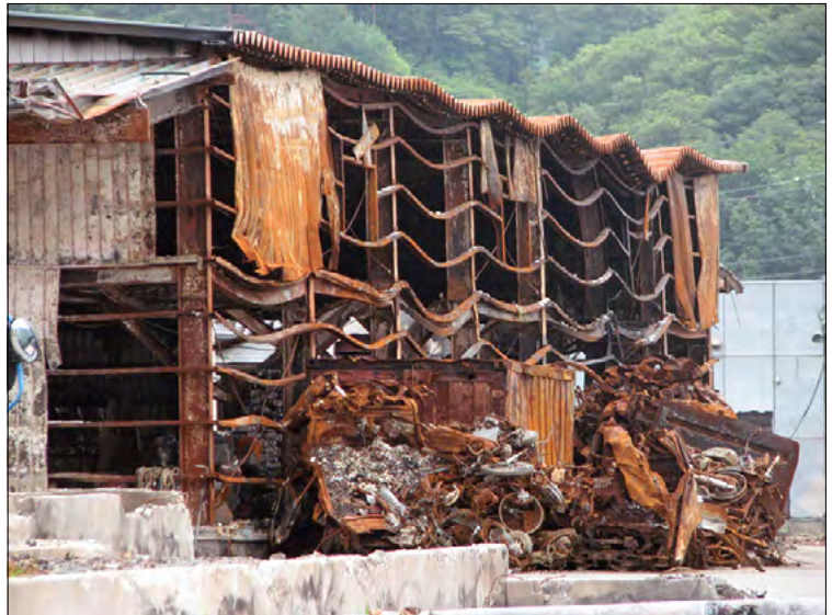
気仙沼市鹿折。津波と火災によって損壊した倉庫か工場。
