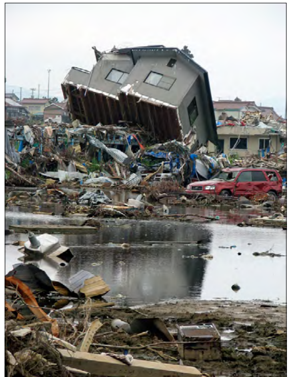
気仙沼市波路上牧。ここでも家が基礎から剥がされ、流されていた。
