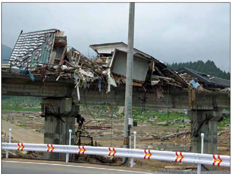
気仙沼市陸前小泉駅近くの鉄橋。鉄橋の上に家や屋根が乗っている。
